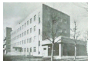
鉄筋コンクリート建て 本館地下1階、地上4階建。 年間分娩数が日本一に。
