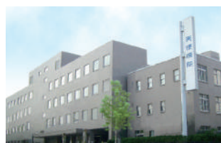
東棟を増築 東棟地下1階、地上4階建。 翌年NICUが認可。
