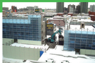
全面新築工事開始 まだまだ雪の多い2月に解体工事が 始まる。
